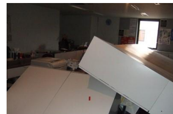
什器の転倒（2階事務室）
