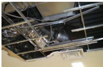
天井材の落下
