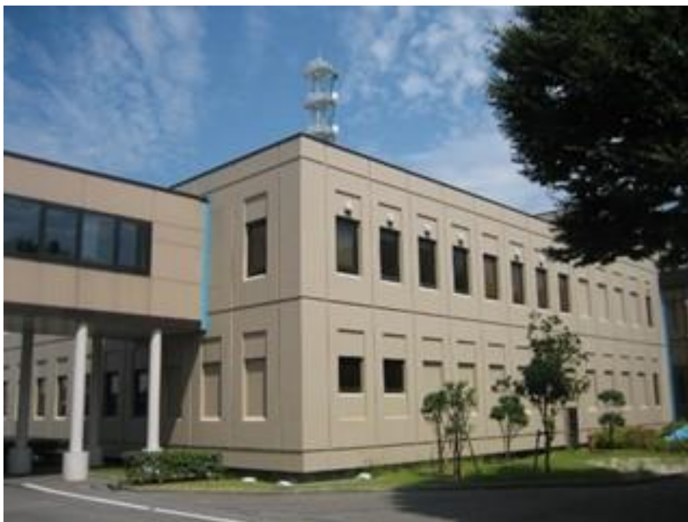
発災直後の事務所本館建物
