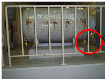
雑固体廃棄物焼却設備プロパン庫
