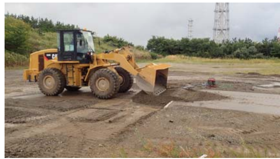
段差復旧状況②
