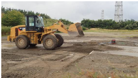
段差復旧状況③
