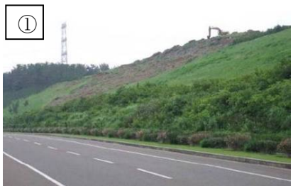
土捨場北側斜面（近景）
