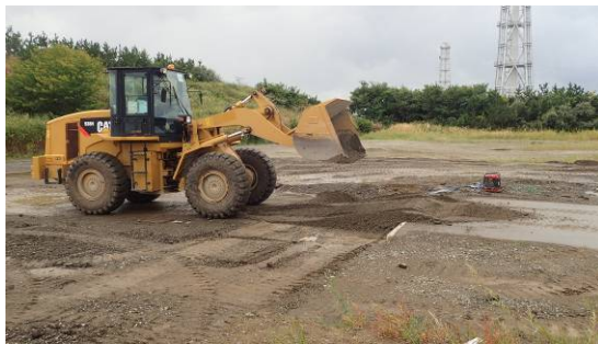
段差復旧状況③
