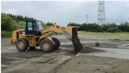
段差復旧状況①
