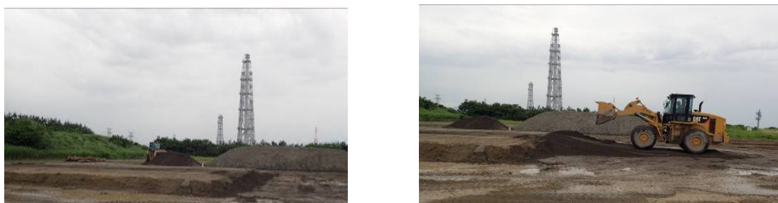
図 6 段差復旧状況
