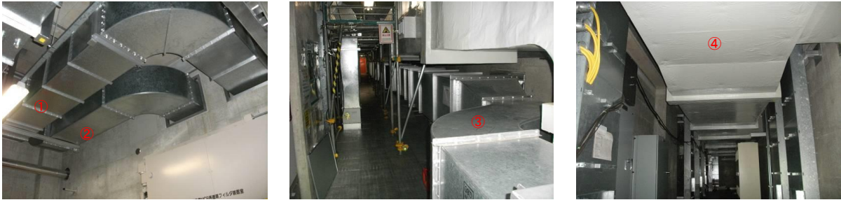
図 2.1.4-3 バウンダリ外ダクト敷設状況
