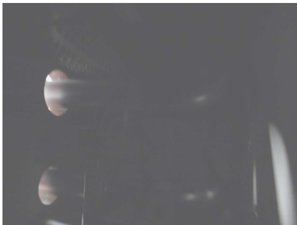
配管補修箇所（可搬型照明なし）
