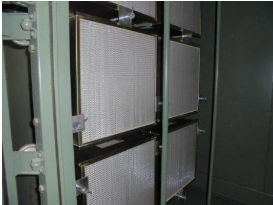
(高性能フィルタの取付け状態)
