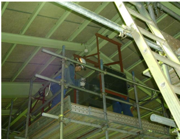
図 2.1.4-8 ダクト修復 作業訓練の例
