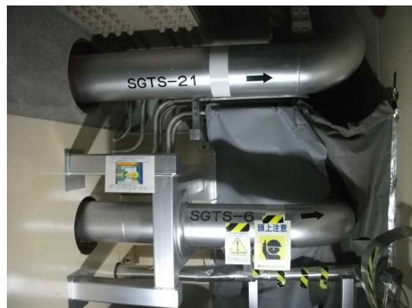
配管補修箇所（可搬型照明2台使用）
