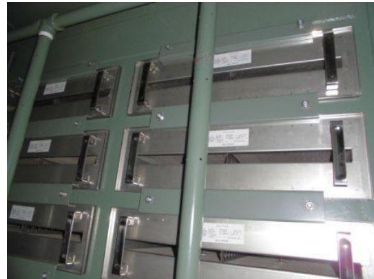
(活性炭フィルタの取付け状態)
