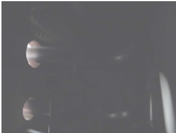
配管補修箇所（可搬型照明なし）
