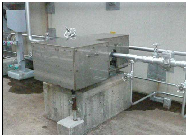
図 5-2 燃料移送ポンプ外形写真
