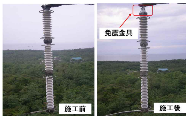
第2.2.4-13図 免震金具取付の施工状況
