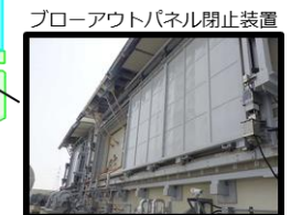
ブローアウトパネル閉止装置
