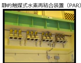
静的触媒式水素再結合装置（PAR）
