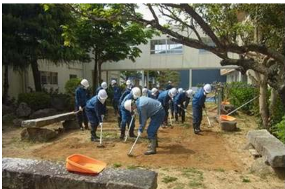
【学校施設における簡易除染作業】
