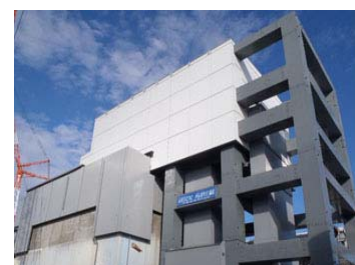
【外観(燃料取出し用カバー)】
