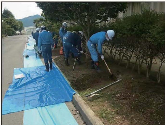
【簡易除染の様子】
