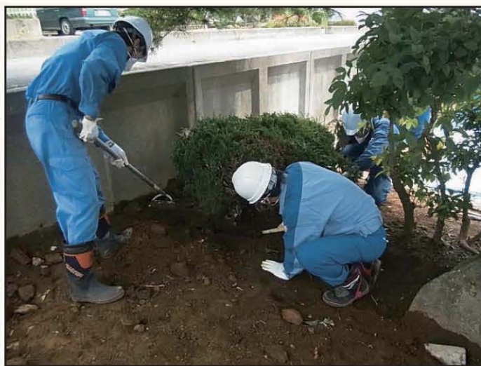
【簡易除染の様子】
