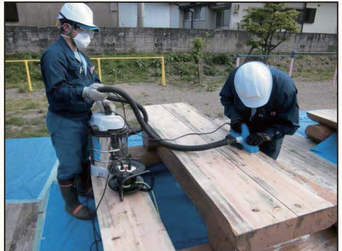
【簡易除染の様子】
