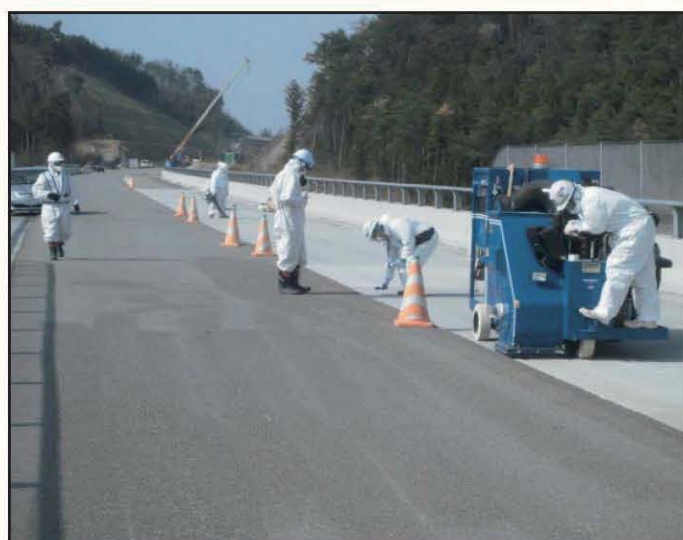
【橋梁部ブラスト作業の様子】
