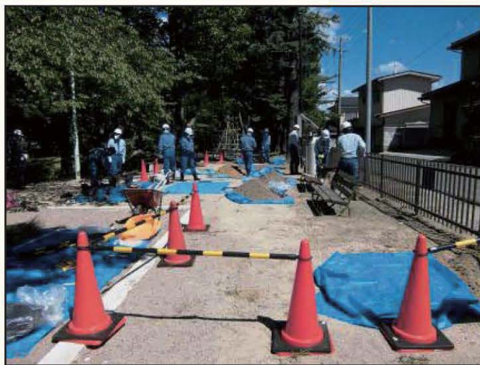
【簡易除染の様子】
