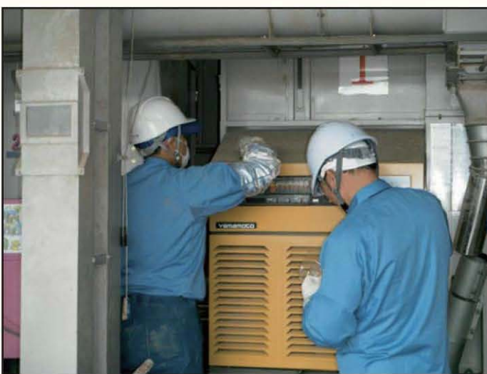
【機械表面の汚染測定の様子】
