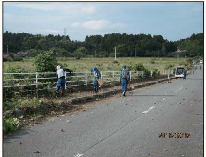
除草後の清掃【平成25年9月12日】
