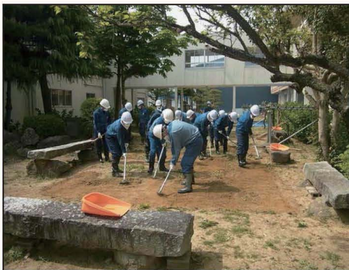
【簡易除染の様子】
