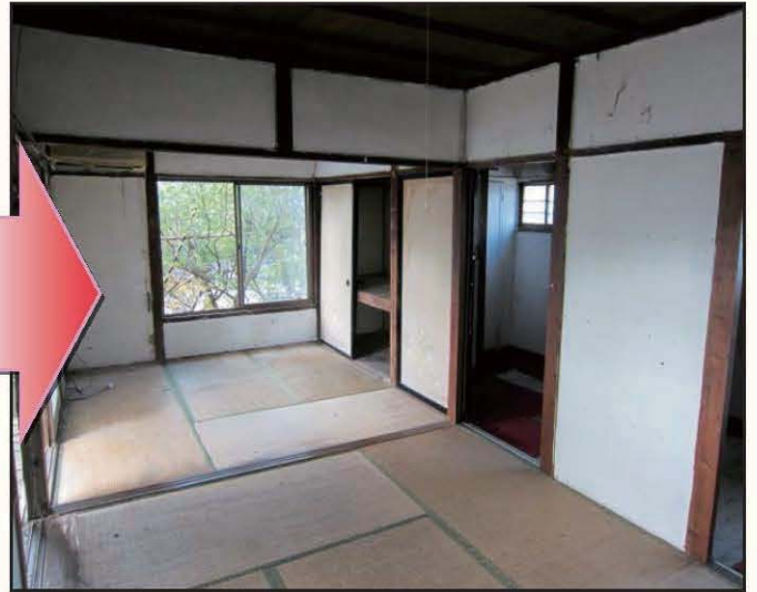
片付け後の様子【平成25年12月4日】
