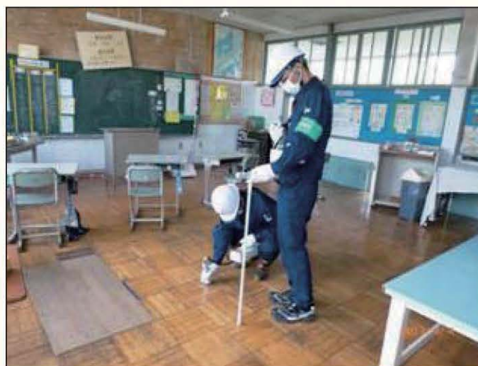
【校舎内でのモニタリング作業】
