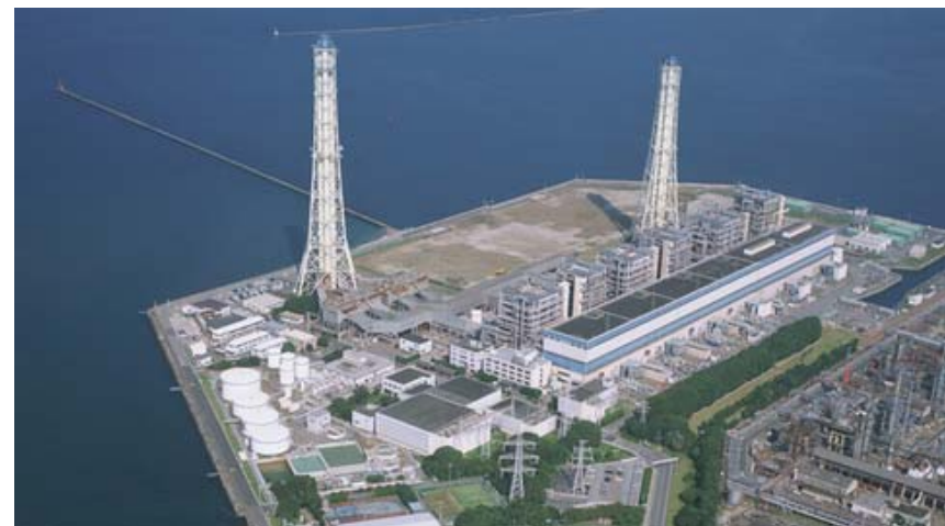
現在の五井火力発電所
