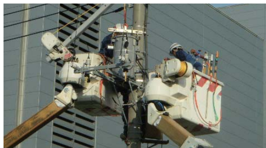
作業工程の組み替えや併行作業の拡大等により変圧器取替工事の時間を短縮
