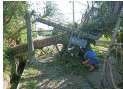
当社作業員による復旧作業状況
