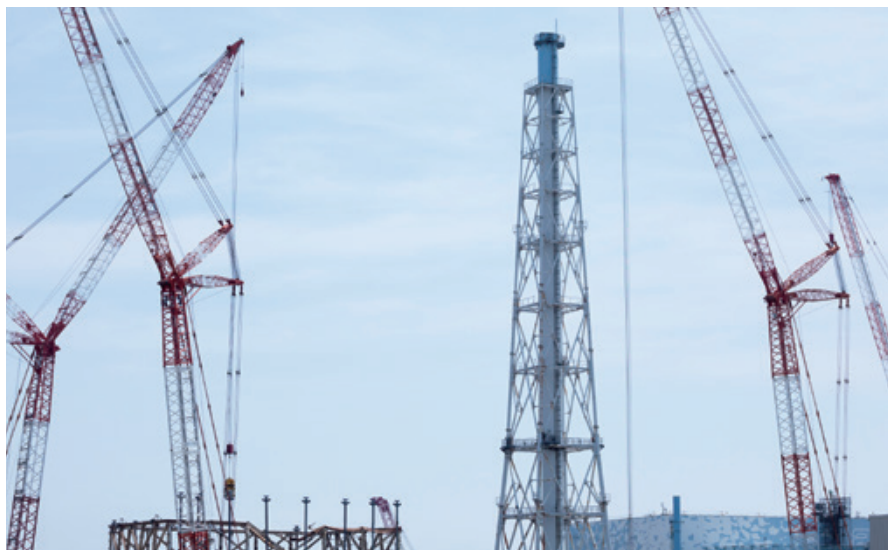
1、2号機排気筒 耐震上の裕度の確保を目的に、半分程度の高さにする解体工事を開始(2019年8月)
