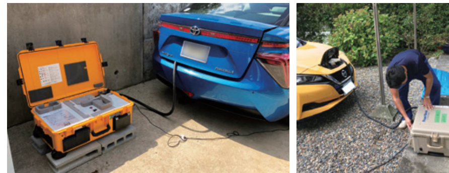
停電地域での給電の様子
