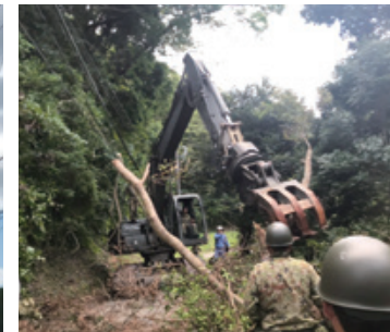
自衛隊による作業状況
