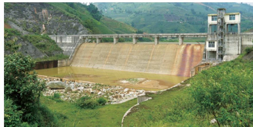
ベトナム国コクサン水力発電所
