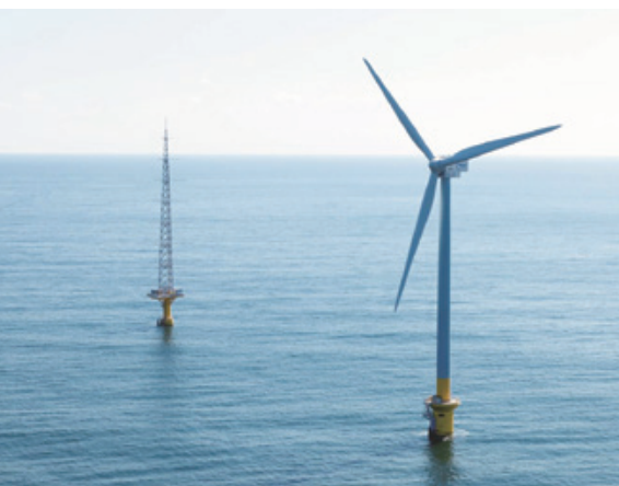
銚子沖風力発電設備と観測タワー(千葉県銚子市)
