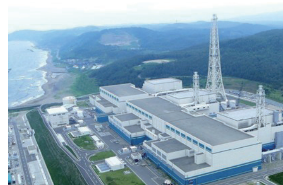
柏崎刈羽原子力発電所
