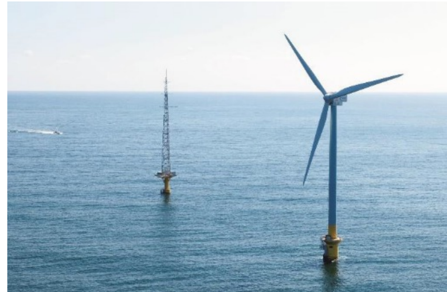
銚子沖洋上風力発電所
