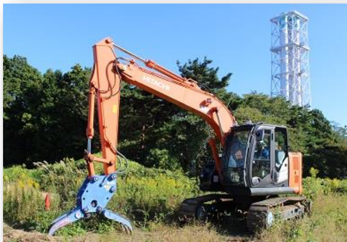
バックホー（解体用）の操作訓練
