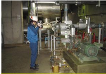
赤外線サーモグラフィ診断
