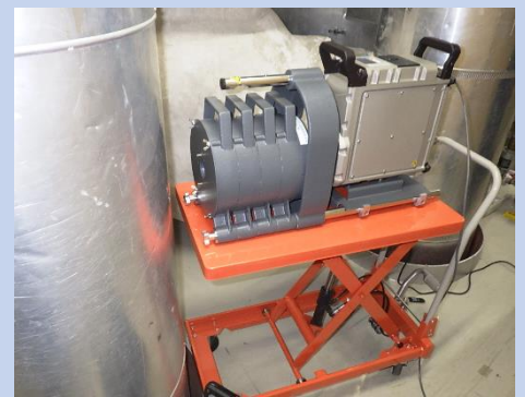
可搬型ゲルマ測定器*4による 配管内付着放射能測定
