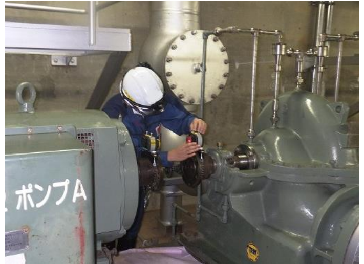
ポンプとモーターの中心軸を調整している様子
