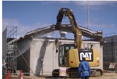
3,4号炉予備ポンベ建屋の解体作業の様子 (2022年3月29日完了)
