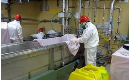
CRD補修室内の汚染除去作業の様子 (2021年9月27日完了)
