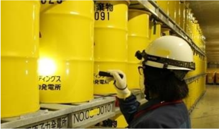
放射性固体廃棄物の保管状態を点検している様子
