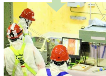
撮影した映像で燃料の状態を確認
