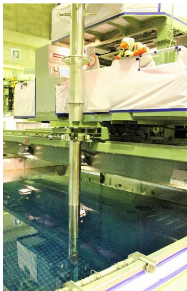
1号機燃料交換機を運転し、燃料を移動
