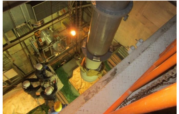
クレーン操作によるポンプの据付
