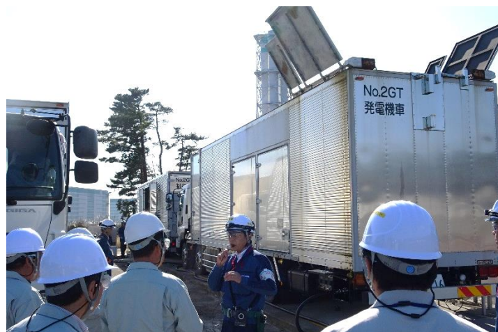
震災後に配備したガスタービン発電機車
