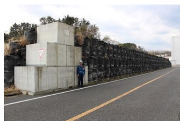
防潮堤（仮設：海拔15.4m）
