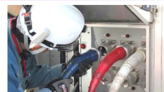
電源車へのケーブル接続
