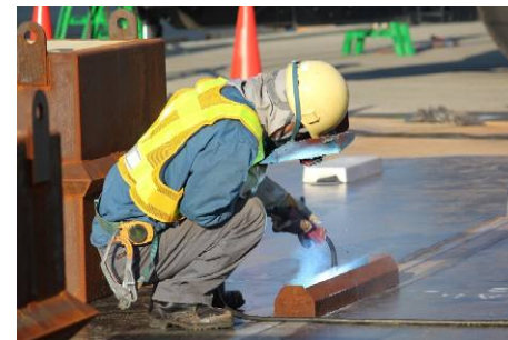
溶接型タンクの作業風景
