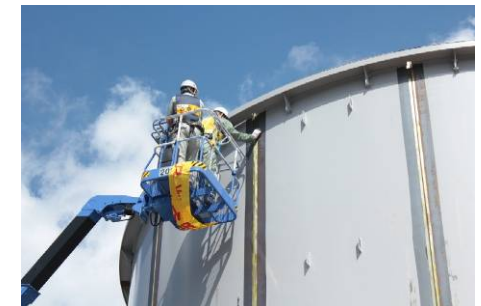
溶接箇所を確認をしている様子
