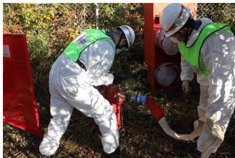
消火栓を使っでの給水車への給水
