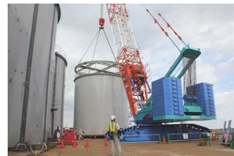
大型クレーン（吊上荷重約500t）での輸送船へのタンクの移動
