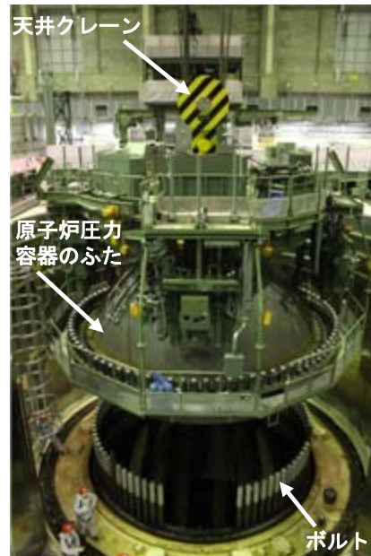
原子炉圧力容器のふたのとりはずし
