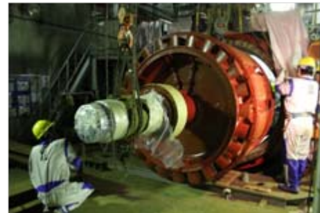
発電機の組み立て（平成24年8月）
