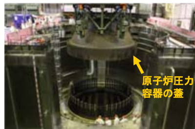
原子炉建屋天井クレーンを使用して原子炉圧力容器の蓋の取り外しを行っている様子 【写真は2号機原子炉開放時のもの】
