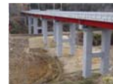
工事後の金山橋
