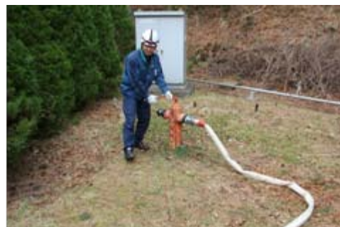
消火栓の操作
