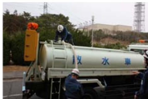
給水車への水張り
