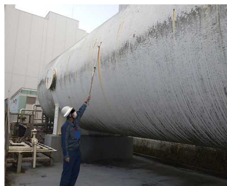
設備表面の放射線測定
