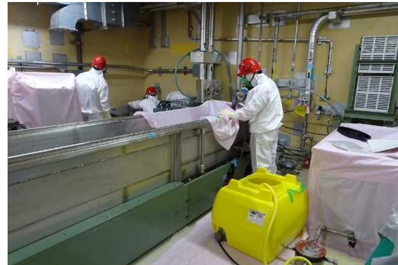
3号炉除染作業
