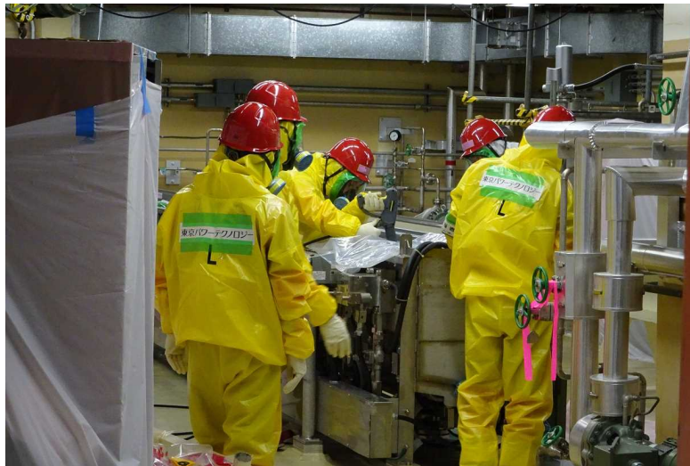
1号炉除染作業
