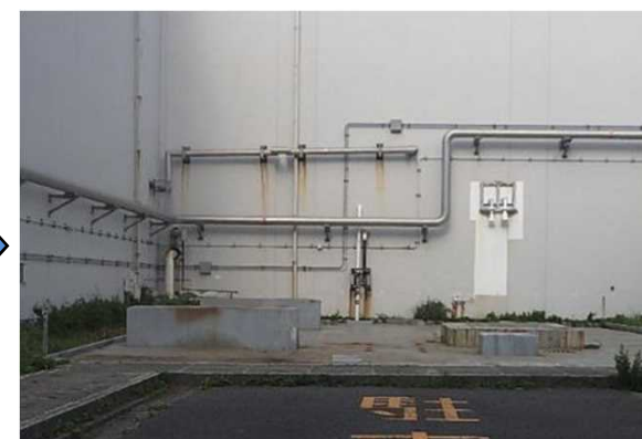
2023年6月 解体撤去後
