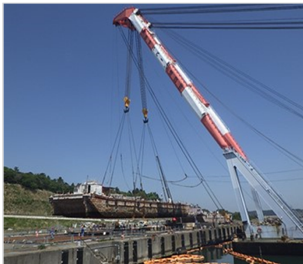
起重機船による陸揚げ
