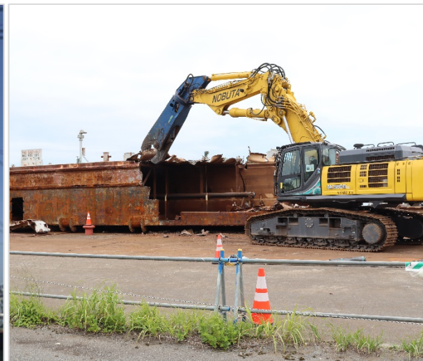
重機による解体
