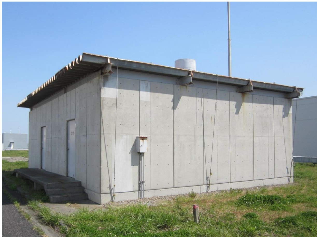
解体撤去前の3,4号炉予備ポンベ建屋
