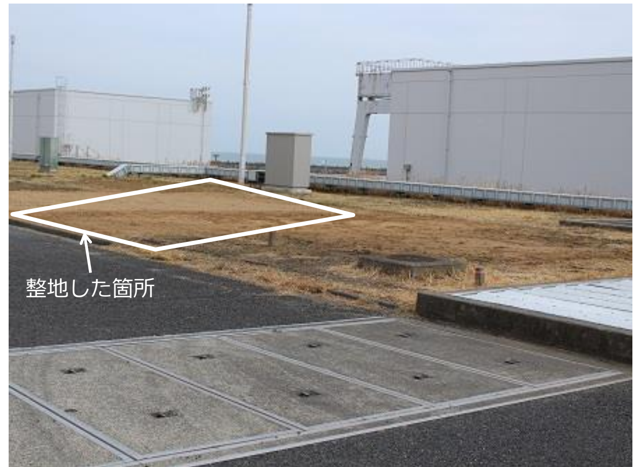
解体撤去完了後の整地
